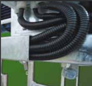
Alle elektriciteitskabels zijn voorzien van bescherming, en netjes weggewerkt.
